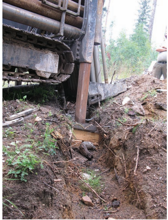
Kuva 10. Porauksen valmistelu on helpompaa, kun kaivutyöt suoritetaan porauksen jälkeen. Kuvat: Janne Juvonen
