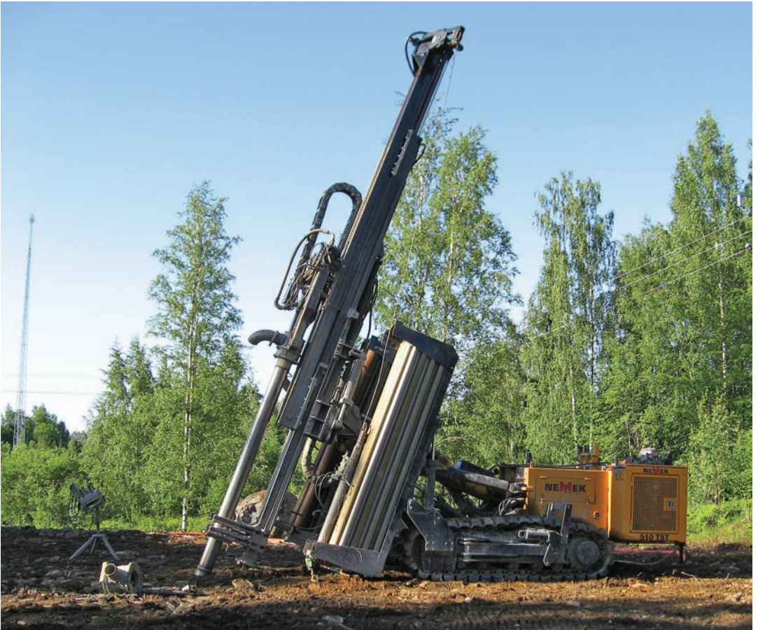
Kuva 9. Vinoreiän poraus. Kuva: Tuija Hoikkala
