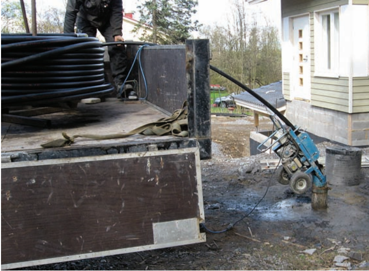
Kuva 13. Keruuputkien asennusta syöttölaitteella. Kuva: Vesa Purakasmäki
