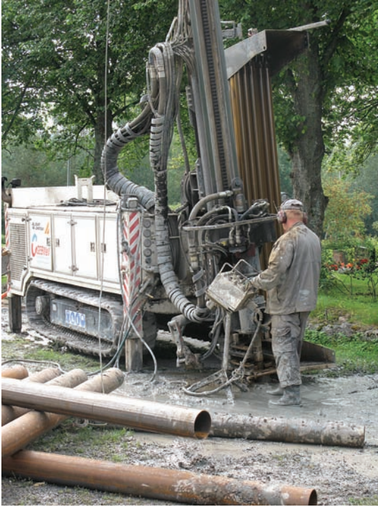
Kuva 10. Porauksen valmistelu on helpompaa, kun kaivutyöt suoritetaan porauksen jälkeen. Kuvat: Janne Juvonen
